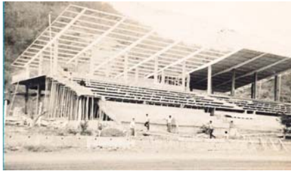
Construcción de las tribunas.
