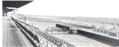
Ya construidas las tribunas se realizaba trabajos finales en la pista
